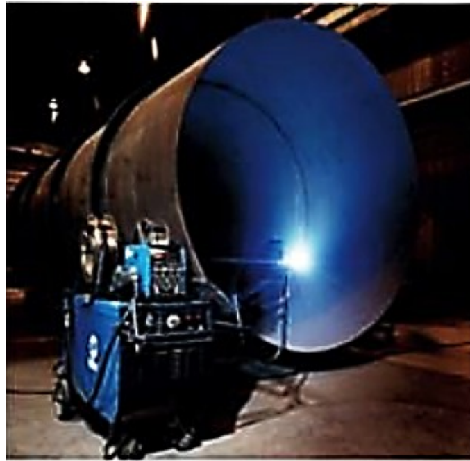
Soldadura MAG de acero al carbono.
